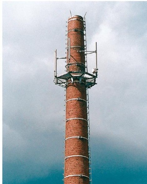
Realisierung einer Basisstation an einem Industrieschornstein
